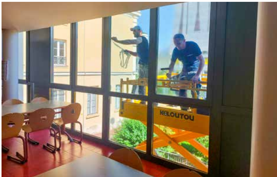
L'application d'un vernis sur les fenêtres des écoles (ici, l'école Cabourg) permettra de diminuer la température de plusieurs degrés à l'intérieur des établissements.
