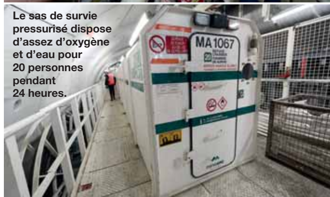
En route pour rejoindre le tunnelier, deux kilomètres plus loin.
